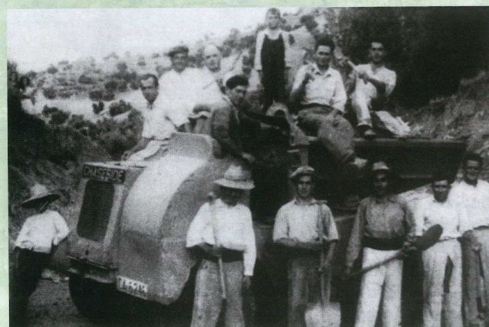
Dumper Chaseside empleado en la última fase de la construcción de la línea de Jerez a Almargen. [AVVA]
