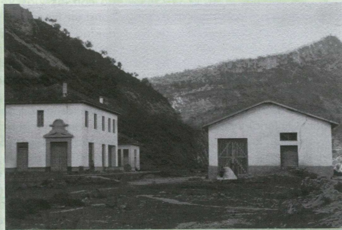
Estación de Coripe ya finalizadas las obras de construcción y a falta de unas vías que nunca llegaron. [Ayuntamiento de Jerez]
