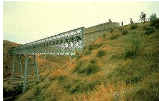
PUENTE EN USO DENTRO DE UNA VÍA VERDE
